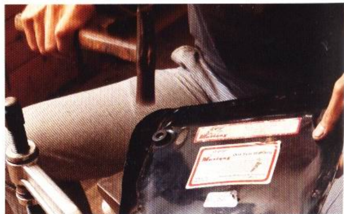
4 使用電鑽將鉚釘取下之後，有時候鋼板會彎曲，所以要用榔頭敲打鋼板來進行修正工作。
